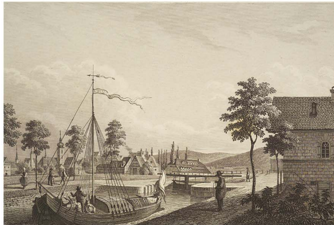
Schleuse 93 bei Forchheim, 1847
