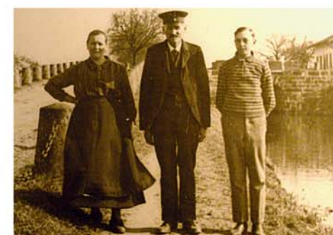
Die Schleusenwärterfamilie Körber bei der Schleuse 94, um 1935
