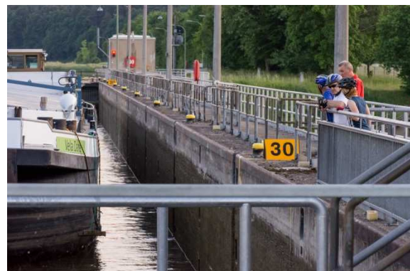
Schleuse Hausen am RegnitzRadweg Foto: Markus Hammrich
